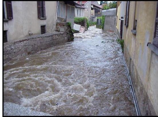
Fig. n. 6.6 – Esondazione Lenza maggio 2002, vista da via Monte Grappa verso valle, si osservi il muro d'argine crollato.
