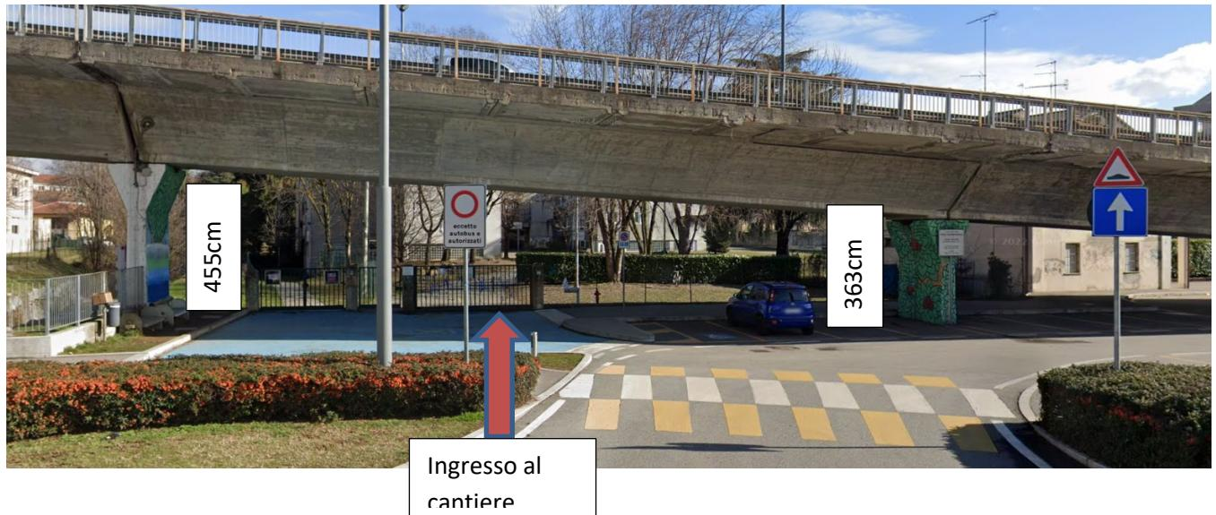
In mezzaria del campo tra due piloni l'altezza è di 410 cm che costituisce un limite al passaggio dei mezzi di cantiere.
